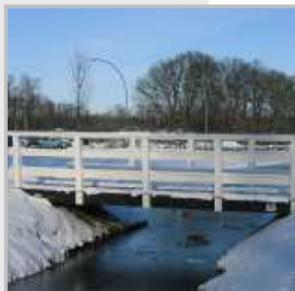
Un importante sviluppo nei Prodotti Riciclati della Lankhorst è che la plastica riciclata KLP® può essere rinforzata con l'acciaio. La Lankhorst combina plastica e acciaio, per consentire di creare luce. Ciò significa, per esempio, che la costruzione di un ponte o di un pontile necessiterà di un numero inferiore di pali e in tal modo i costi totali di produzione e di materiale saranno molto inferiori.
